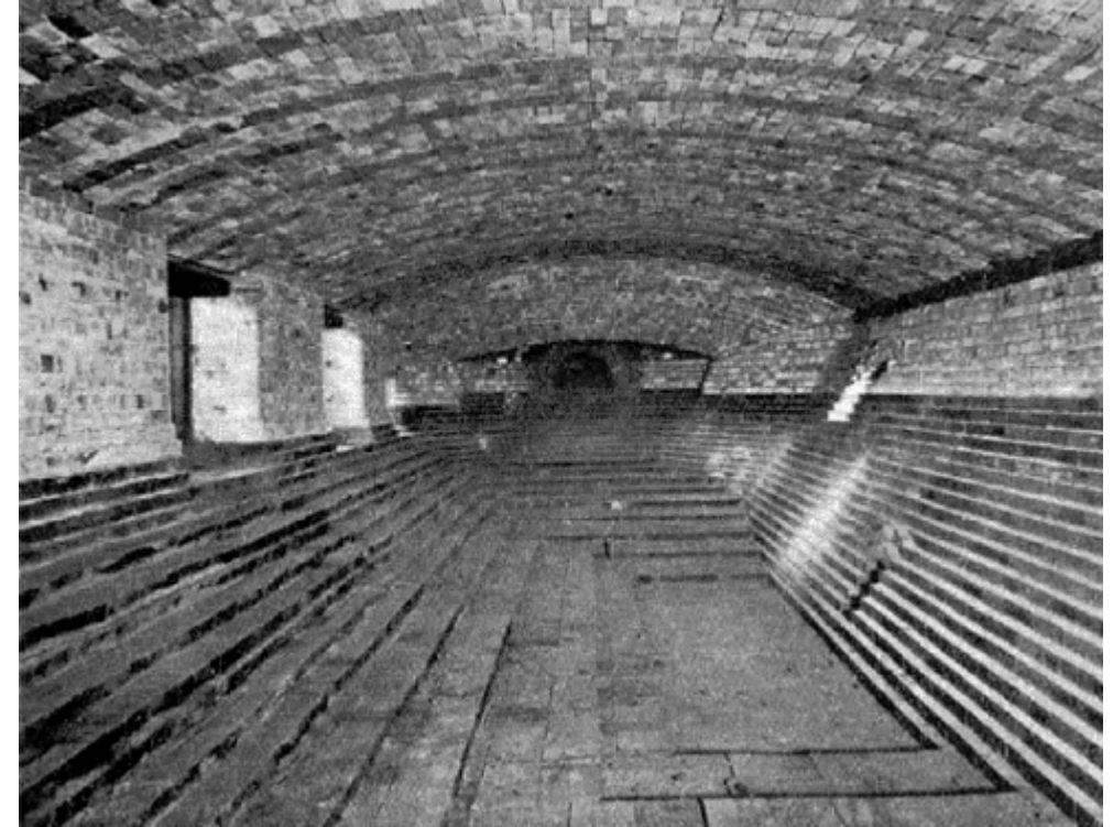
A Siemens-Martin kemence belseje
